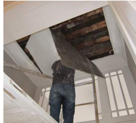
↑ Desprendimiento de plafones en Altamirano 20, 21 de marzo de 2012, 13:58 horas ↗ Desprendimiento de plafones en Pomona 36, 21 mayo 2012, 11:26 horas
